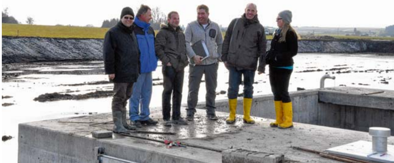
Auf dem neuen Regenklärbecken beim Regenrückhaltebecken am Talbachgraben beim Gewerbegebiet Bad Dürrheim stehen: Tiefbauamtsleiter Christof Rösch, Klärmeister Reinhold Moser, der Bauleiter der Erdbaufirma A.A. Müller Matthias Roher, der Bauleiter des Ingenieurbüros Ernst und Co., Markus Bohner, sowie vom Landratsamt Bauingenieur Udo Müller und Studentin Anika Morat (von links). BILD: KURZ
