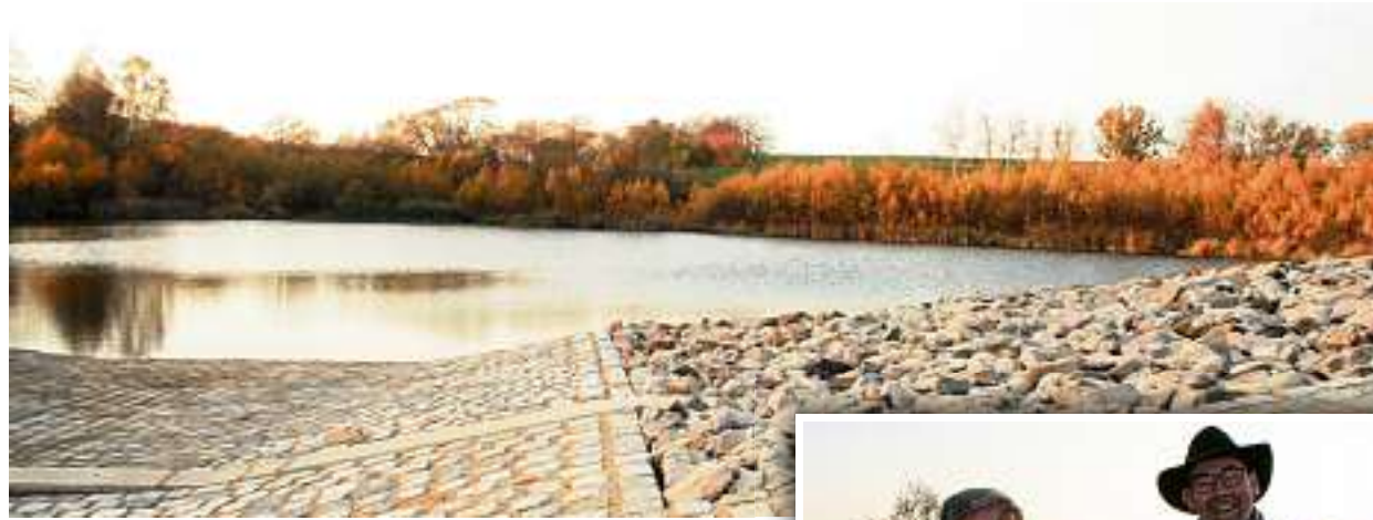
Die Talsperre in Zoppoten ist bereits seit 2013 den gesetzlichen Anforderungen angepasst worden. Fotos (2): Sophie Filipiak
