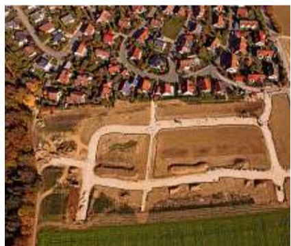
Ein Blick auf das Baugebiet Reutäcker von oben. BILD: JULIAN GOMBOLD
