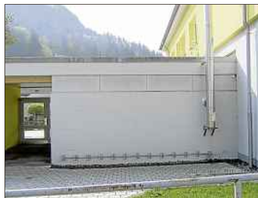
An der Westseite der Pausenhalle wird das Betonfertigteilgebäude aufgestellt, in dem ein Netzknotenpunkt für das FTTB-Netz installiert werden soll. Foto: Wössner
